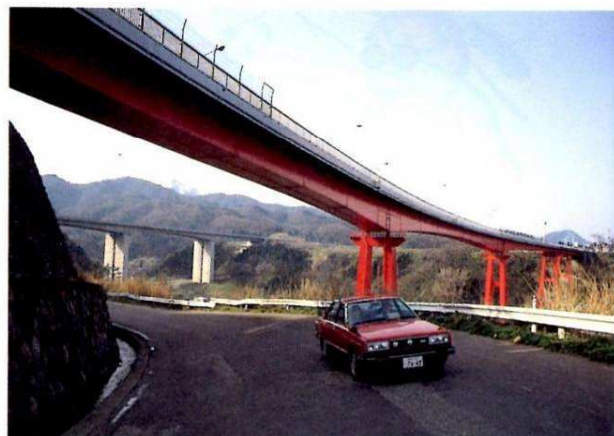
国道に出て米山大橋をくぐる。真っ赤な高い橋脚が美しい。
