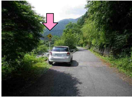
12図先 『落石注意』 標識 手前の木で見にくいので注意。 木の手前に『駐車遠慮願います』看板あり
