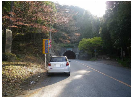
32図先『須花坂トンネル』 左手の「トンネル内点灯」標識
