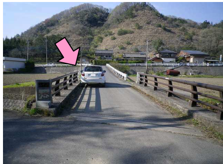
25図『山中橋』出口 左側の橋柱先端
