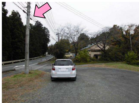
48図 『鎌形八幡神社』前 駐車場 左手の電柱
